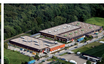
Technique de fabrication NORD Gadebusch
